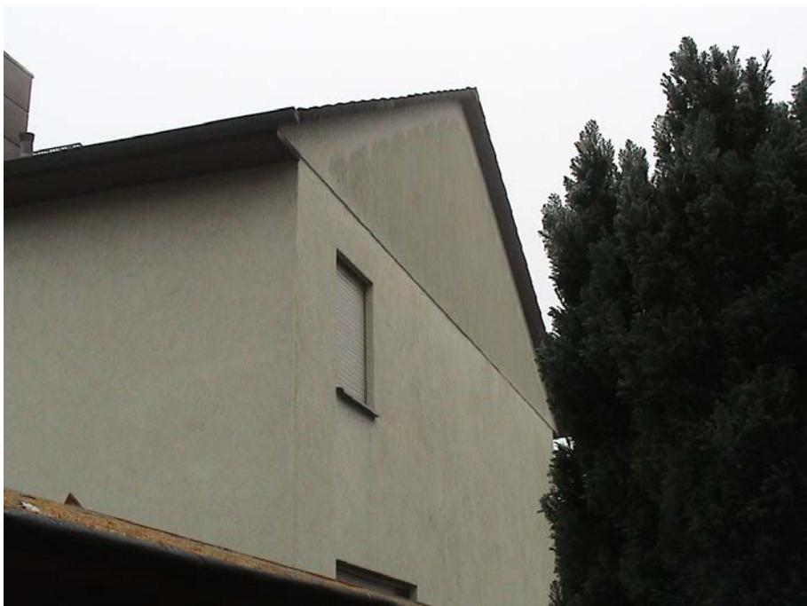
Algen wachsen auf allen (Fassaden-)Oberflächen, die über längere Zeiträume nass sind. Die Fassade selbst muss keinen Nährboden darstellen, weil Feuchtigkeit und angewehte Nährstoffe zur Algenbildung ausreichen. Bekannt ist, dass auf trockenen Untergründen keine Algen wachsen. Dies kann man häufig schon daran erkennen, dass direkt unter dem Dachüberstand, in der Regenschutzzone Algen nicht wachsen, während daneben, wo der Regen hinkommt, intensives Wachstum beginnt.
